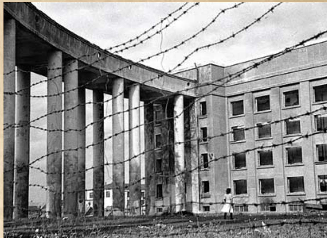
Разрушенное здание Академии наук БССР. Минск. 1944 г.
