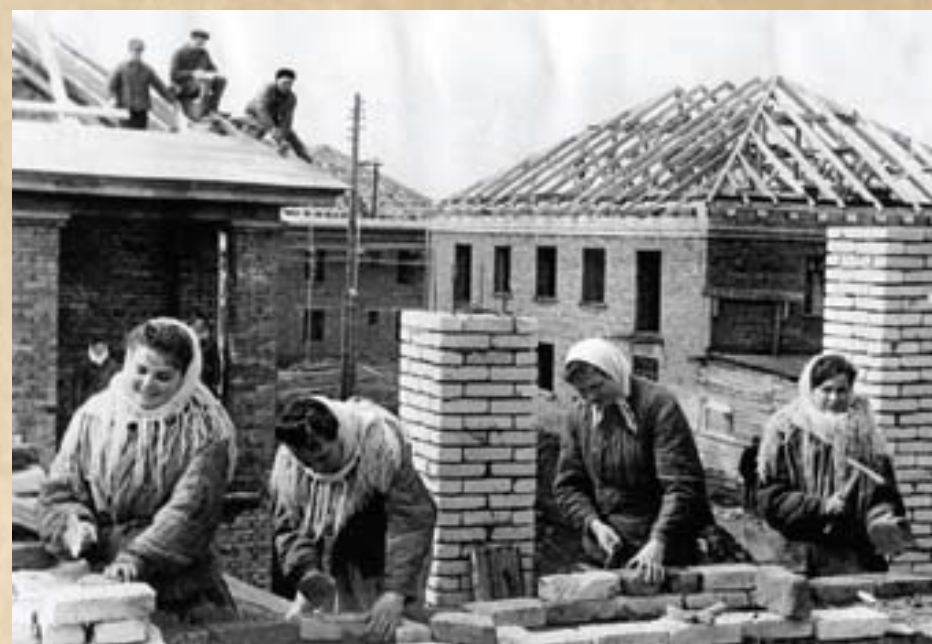
На строительстве жилых домов в рабочем поселке Минского автозавода. 1947 г.
