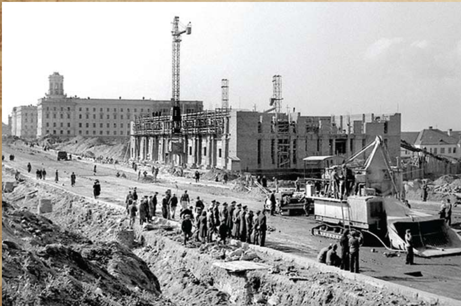
Строительство ГУМа в Минске. Апрель 1948 г.
