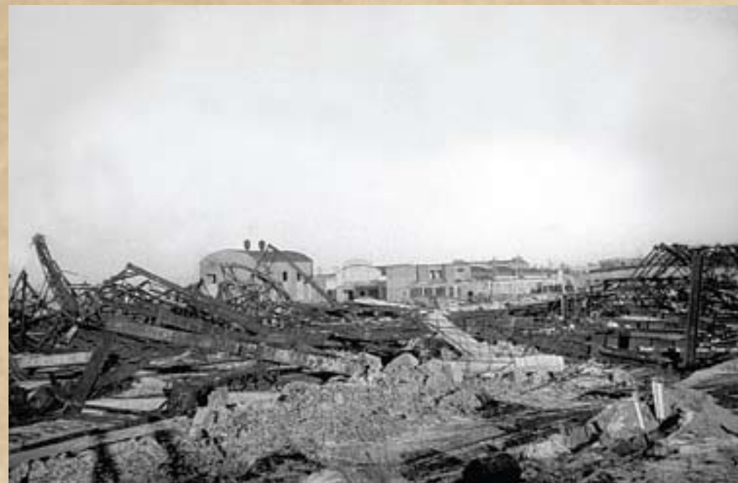
Локомотивный завод в Могилеве, уничтоженный фашистами. 1944 г.
