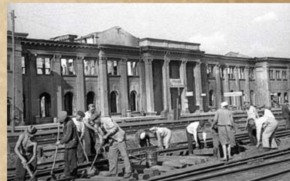
Минчане на восстановлении путей возле разрушенного фашистами здания вокзала. 1944 г.
