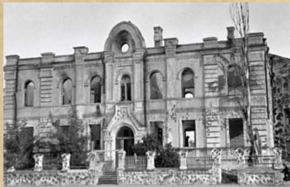
Разрушенный дом на улице Комсомольской в Гомеле. 1944 г.
