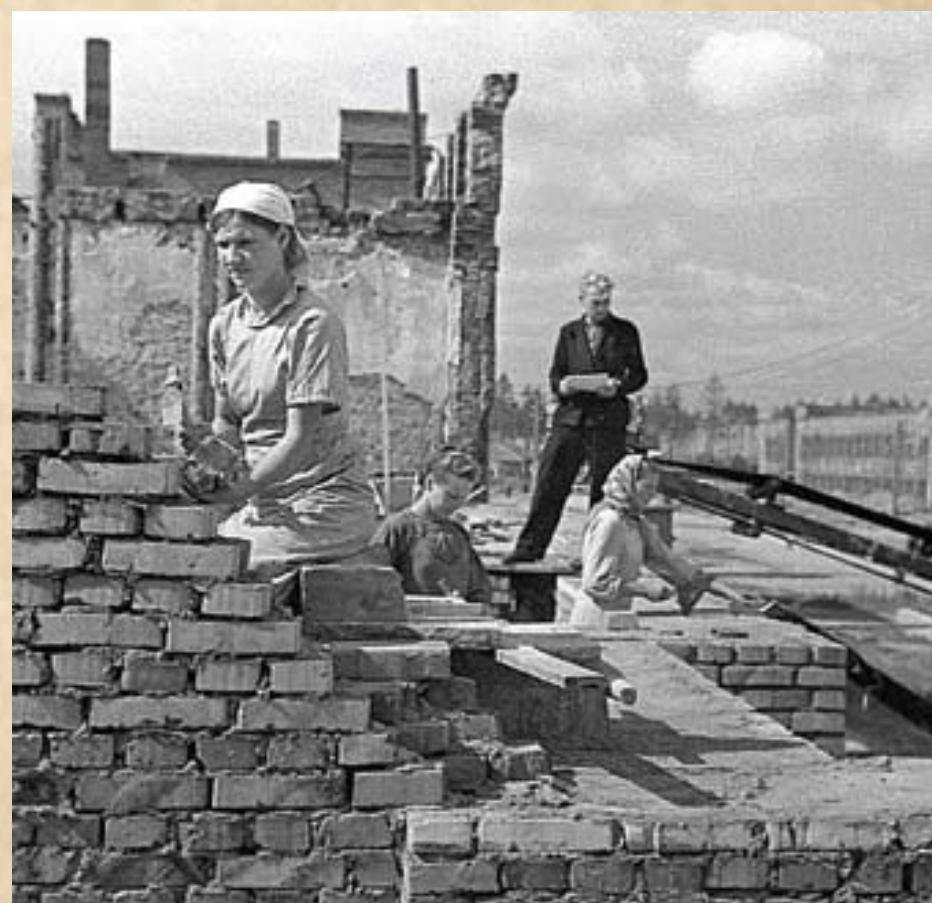
Строительство Минского тракторного завода. 1947 г.
