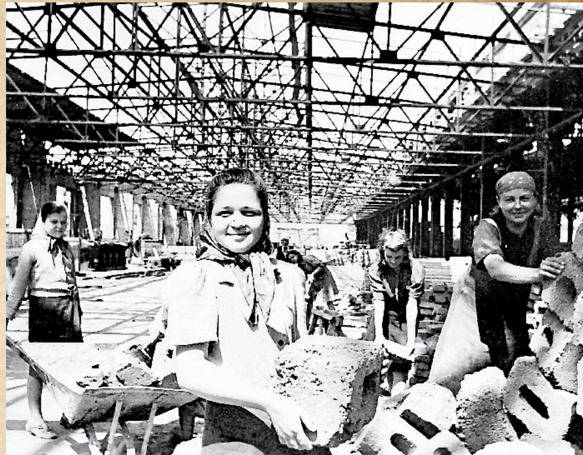
На строительстве Минского автомобильного завода. 1947 г.
