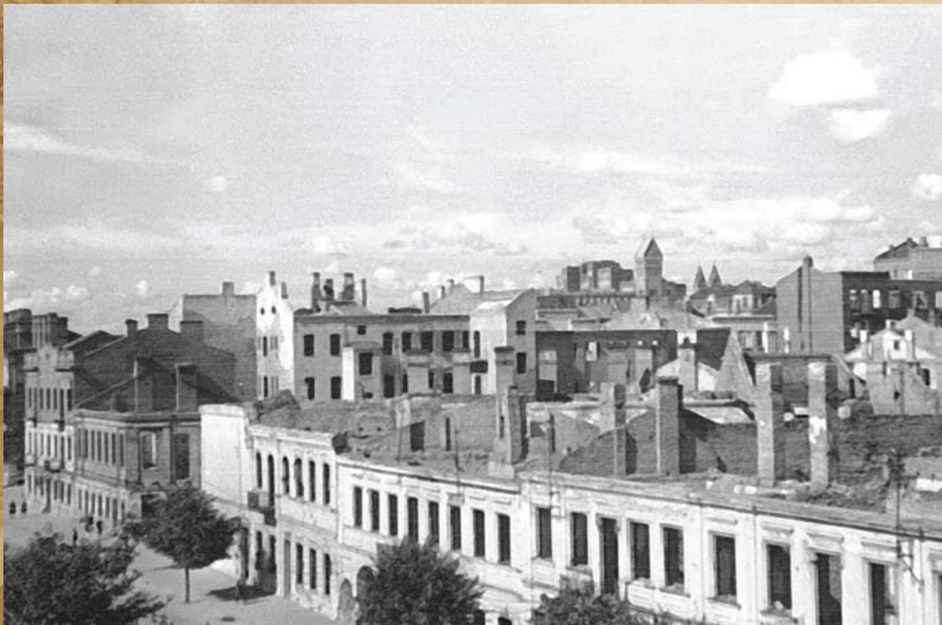
Разрушения на улице Карла Маркса в Минске. 1944 г.
