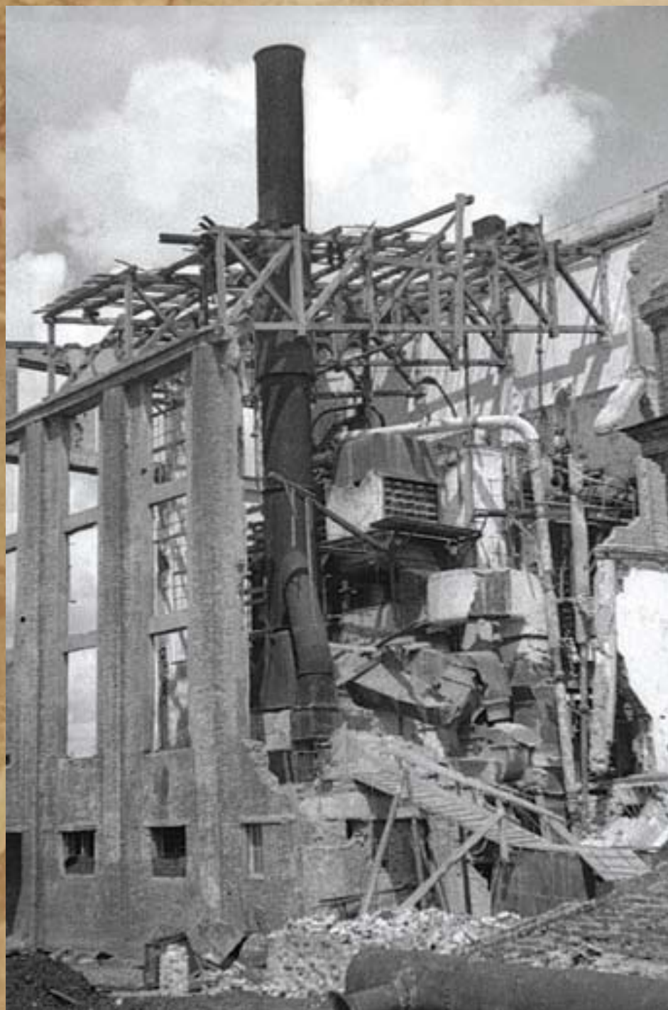
Взорванное гитлеровцами здание электростанции в Гомеле. 1944 г.
